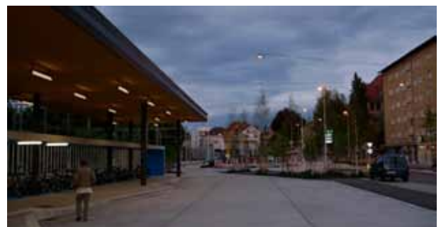
Beispiel: Beleuchtung Platz durch Seilpendelleuchten
